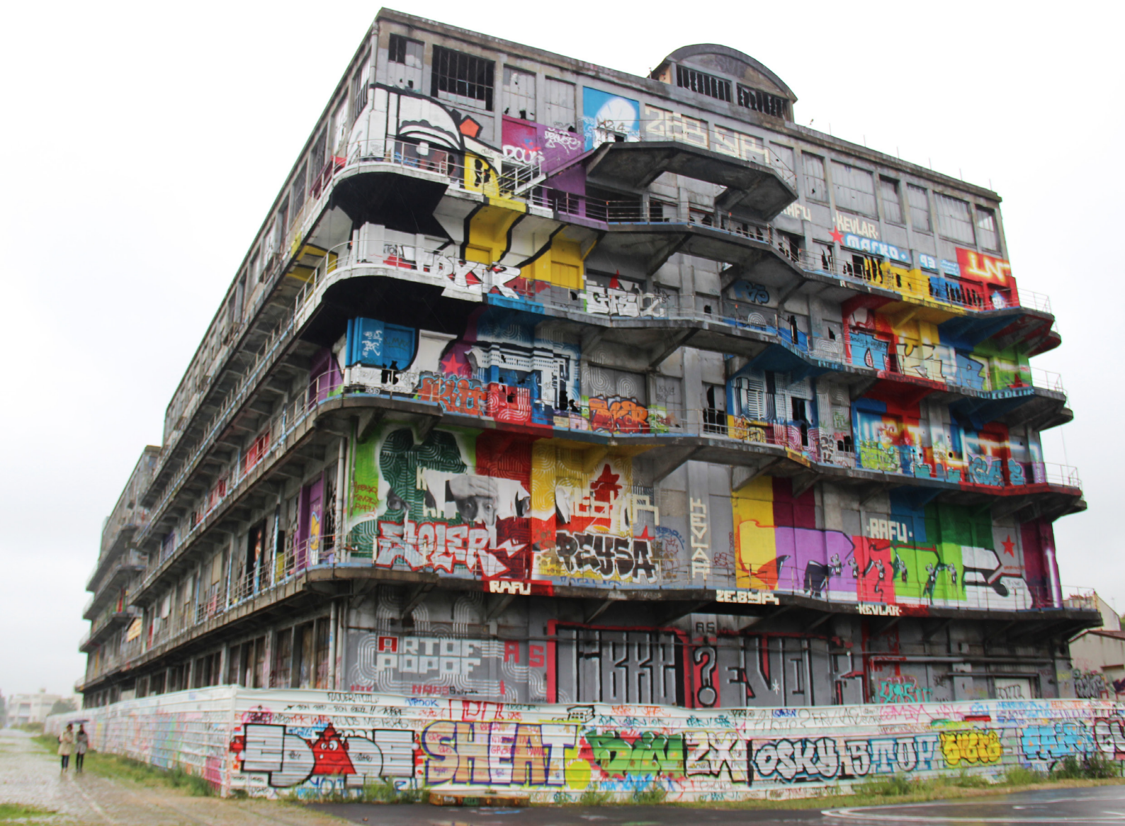
#Pantin | Anciens entrepôts de la Chambre de commerce de Paris – Future siège BETC | Photo de Adamo Maio
