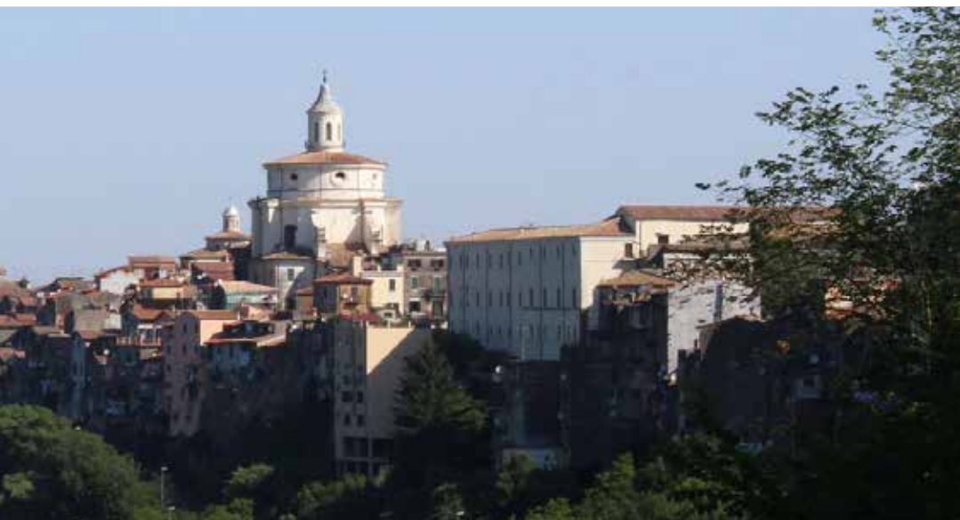
Fig.1_Panoramica del centro storico di Zagarolo.
