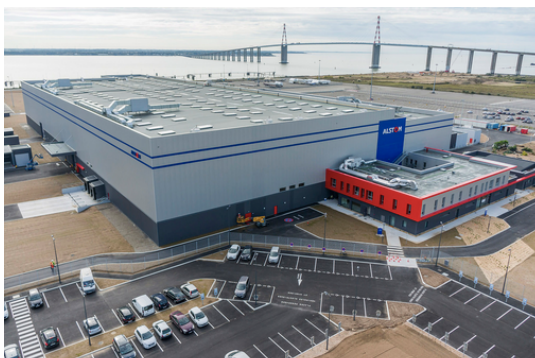
Vue de l'usine General Electric de Saint-Nazaire – inaugurée en décembre 2014
