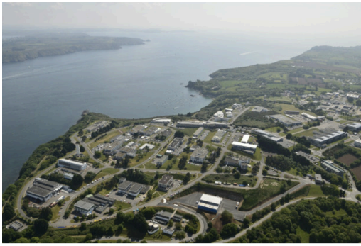
Vue aérienne du Technopôle Brest Iroise (© Thierry Joyeux).
