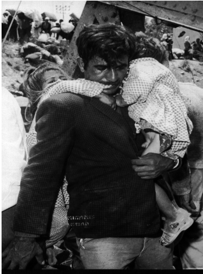
Traversée du Pont Allenby entre la Cisjordanie et la Jordanie, juin 1967 © UNRWA
