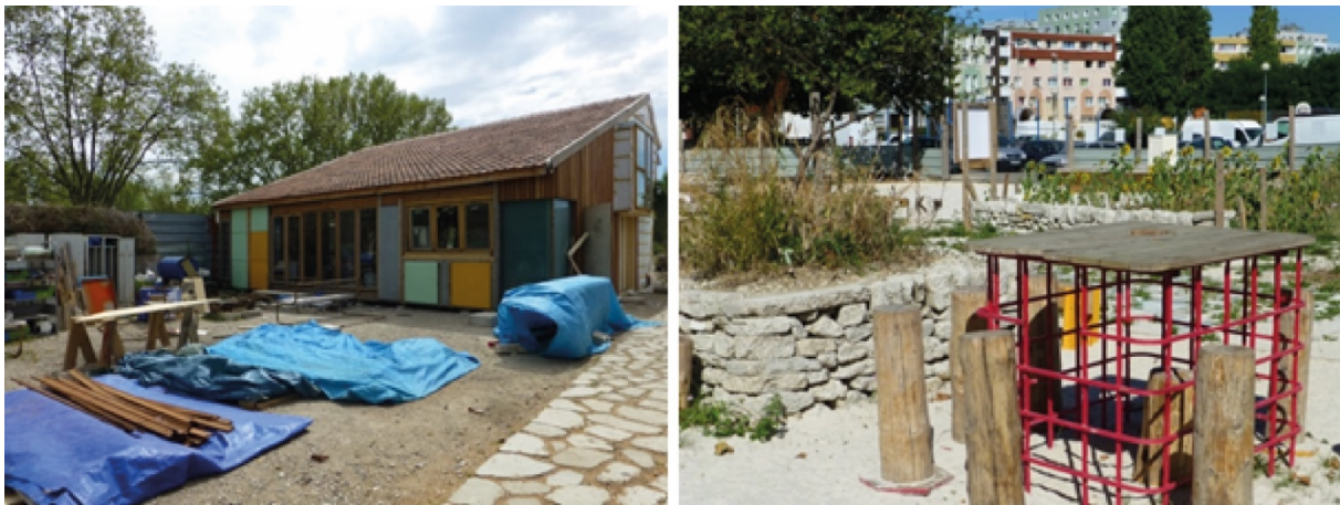
5. Exemples de réemploi des bétons issus de démolition : pavage à Actlab, laboratoire de réemploi de Bellastock sur l'Île-Saint-Denis (gauche) et mobilier pour l'espace public au Clos-Saint-Lazare à Stains (droite) (Agnès Bastin, 2016)
