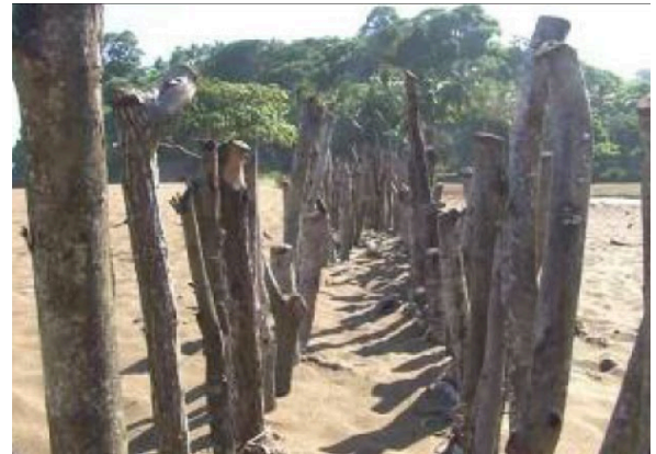
E. digue en bois
