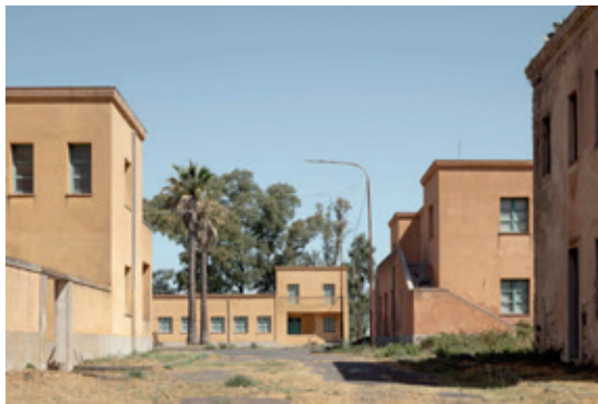
Vue du village de Borgo Rizza, Sicile. Architecte Pietro Gramignani, 1940 Photo © Luca Capuano, DAAR
