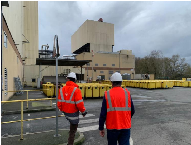
Figure 10 Zone de chargement (Observation, usine d'incinération, 29 février 2024)
