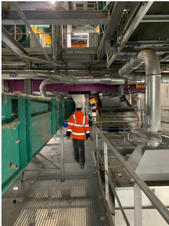
Figure 21 Centre de tri de déchets recyclables (Observation, 4/04/2024)
