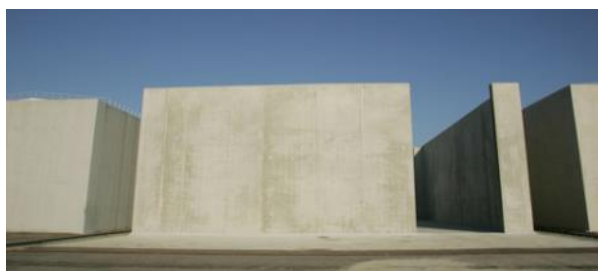
Alvéoles de stockage du CSA (P. Maurein, 2007)
