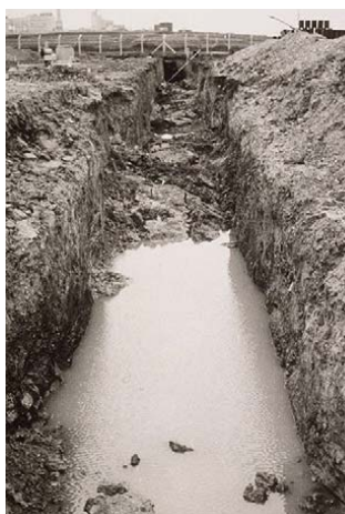
Tranchée ordinaire de stockage de première génération (1969, ANDRA)
