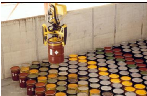
Le site de stockage des déchets à faible et moyenne activité, vie courte (Andra)
