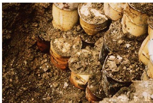
Colis de déchets radioactifs stockés en 1969 à même la terre, en tranchée (Source, Mémoire Détaillée CSM, ANDRA 2008)
