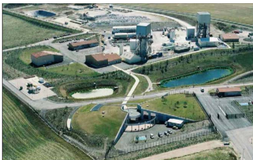
Vue aérienne du Laboratoire de recherche de Meuse/ Haute –Marne ( Dossier de synthèse Argile 2005, Andra )
