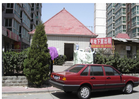
Illustration 37 : Entrée des logements en sous-sol (J. Audin, Z2, mai 2009)
