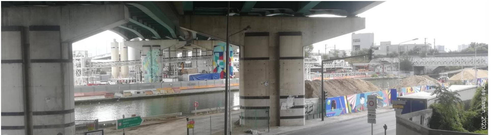
Photo 2. Le canal Saint-Denis à Aubervilliers, sous l'autoroute A86
