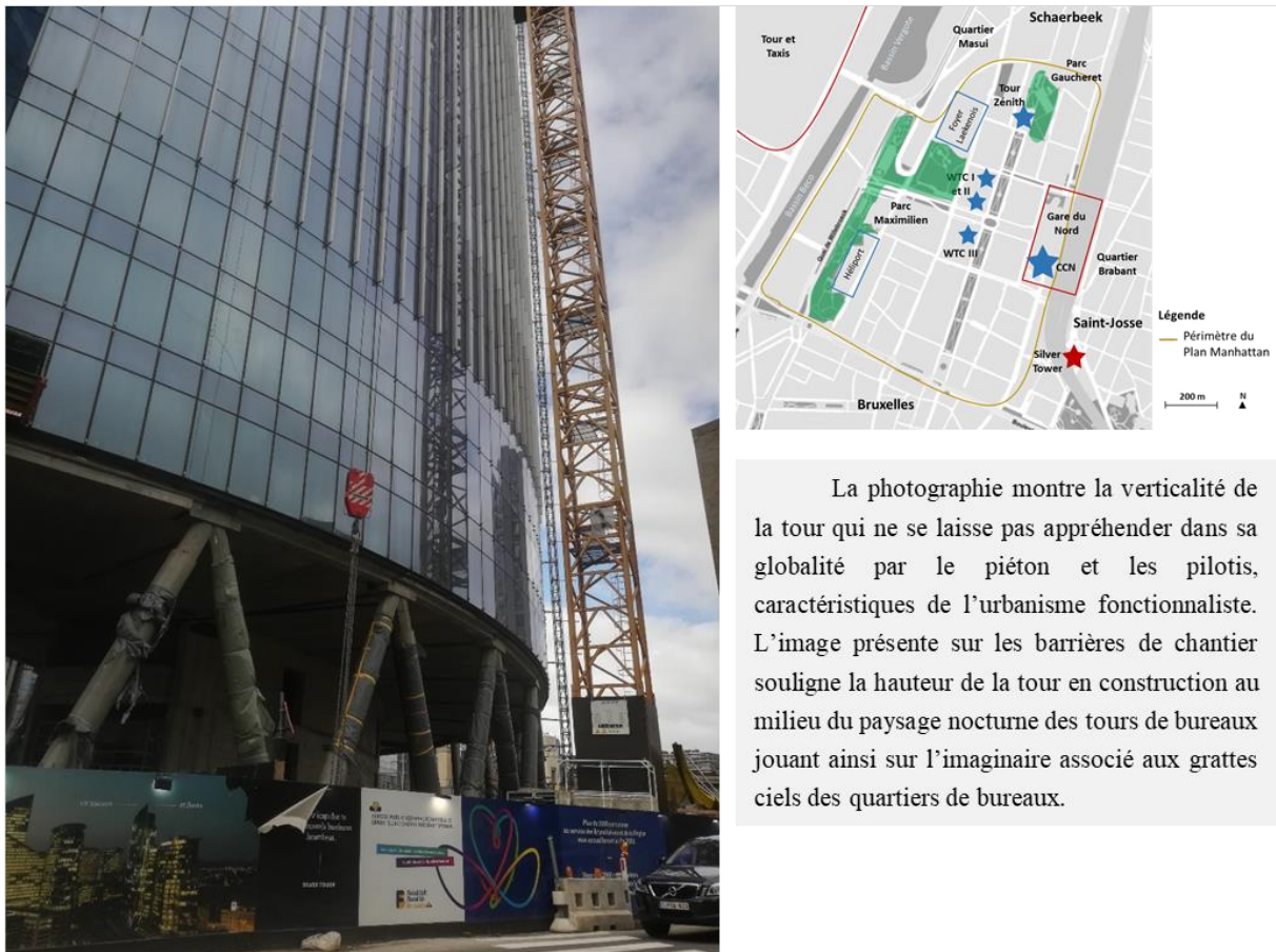
Photo 11. La Silver Tower en construction en 2020
