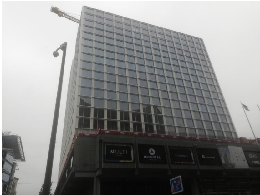
Photo 4. Réhabilitation de la tour de Brouckère (1969) renommée tour Multi
