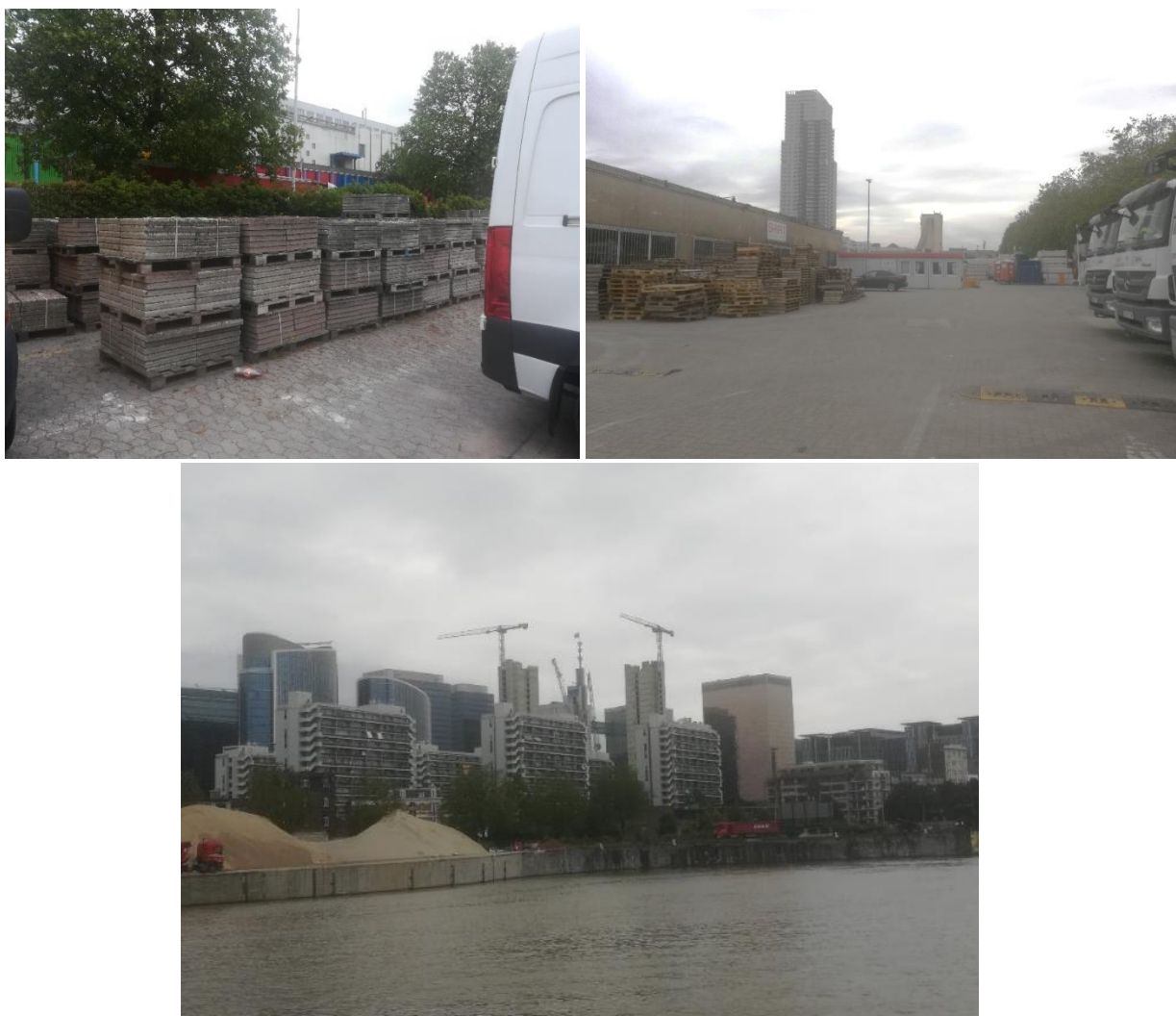
Photo 13. Le Brussels Construction Consolidation Center (BCCC) : stockage des dalles du WTC préparées au réemploi (gauche), vue d'ensemble du hangar et de l'espace de circulation du BCCC (droite), vue du Quartier Nord depuis le quai du BCCC (bas)
