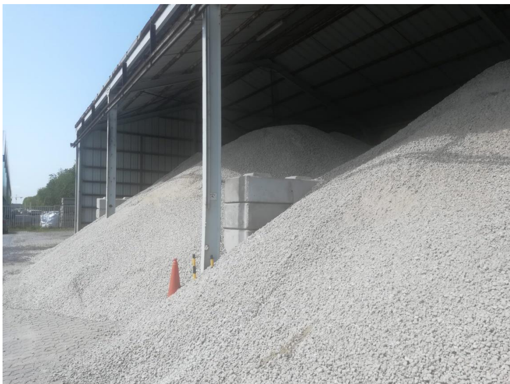
Photo 15. Halle de stockage des granulats recyclés au sein de la centrale à béton
