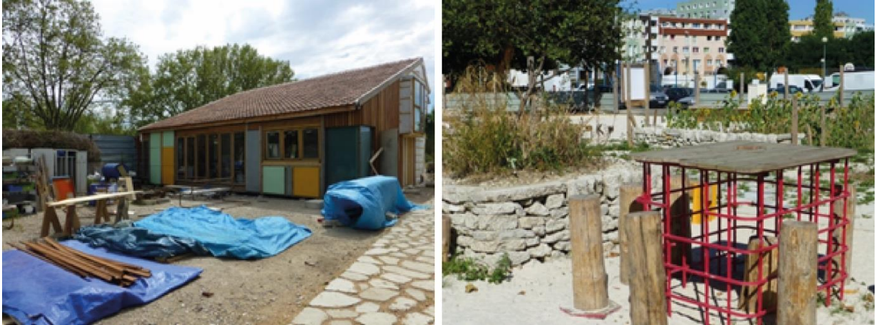
Photo 5. Exemples de réemploi des bétons issus de démolition : pavage à Actlab, laboratoire de réemploi de Bellastock sur L'Île-Saint-Denis (gauche) et mobilier pour l'espace public au Clos-Saint-Lazare à Stains (droite)
