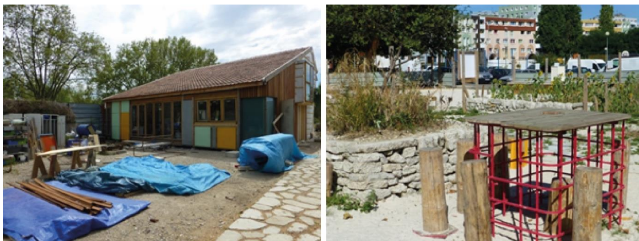
Photo 5. Exemples de réemploi des bétons issus de démolition : pavage à Actlab, laboratoire de réemploi de Bellastock sur L'Île-Saint-Denis (gauche) et mobilier pour l'espace public au Clos-Saint-Lazare à Stains (droite)
