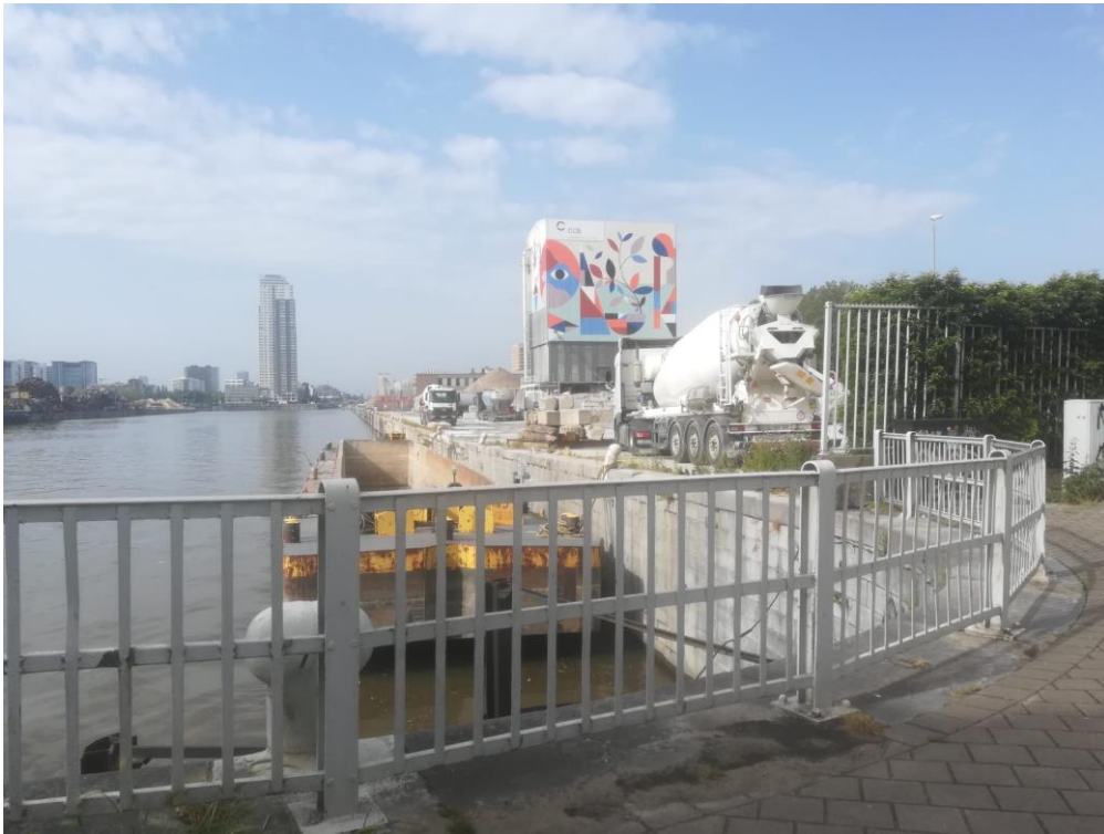
Photo 14. Centrale à béton à Bruxelles
