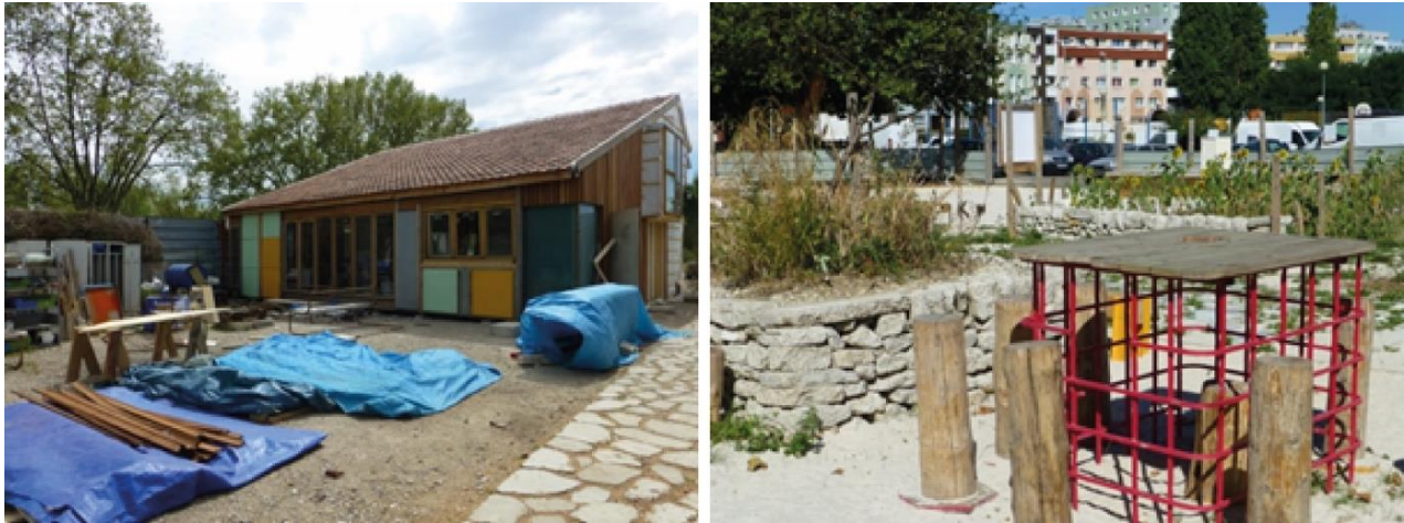
Photo 5. Exemples de réemploi des bétons issus de démolition : pavage à Actlab, laboratoire de réemploi de Bellastock sur L'Île-Saint-Denis (gauche) et mobilier pour l'espace public au Clos-Saint-Lazare à Stains (droite)
