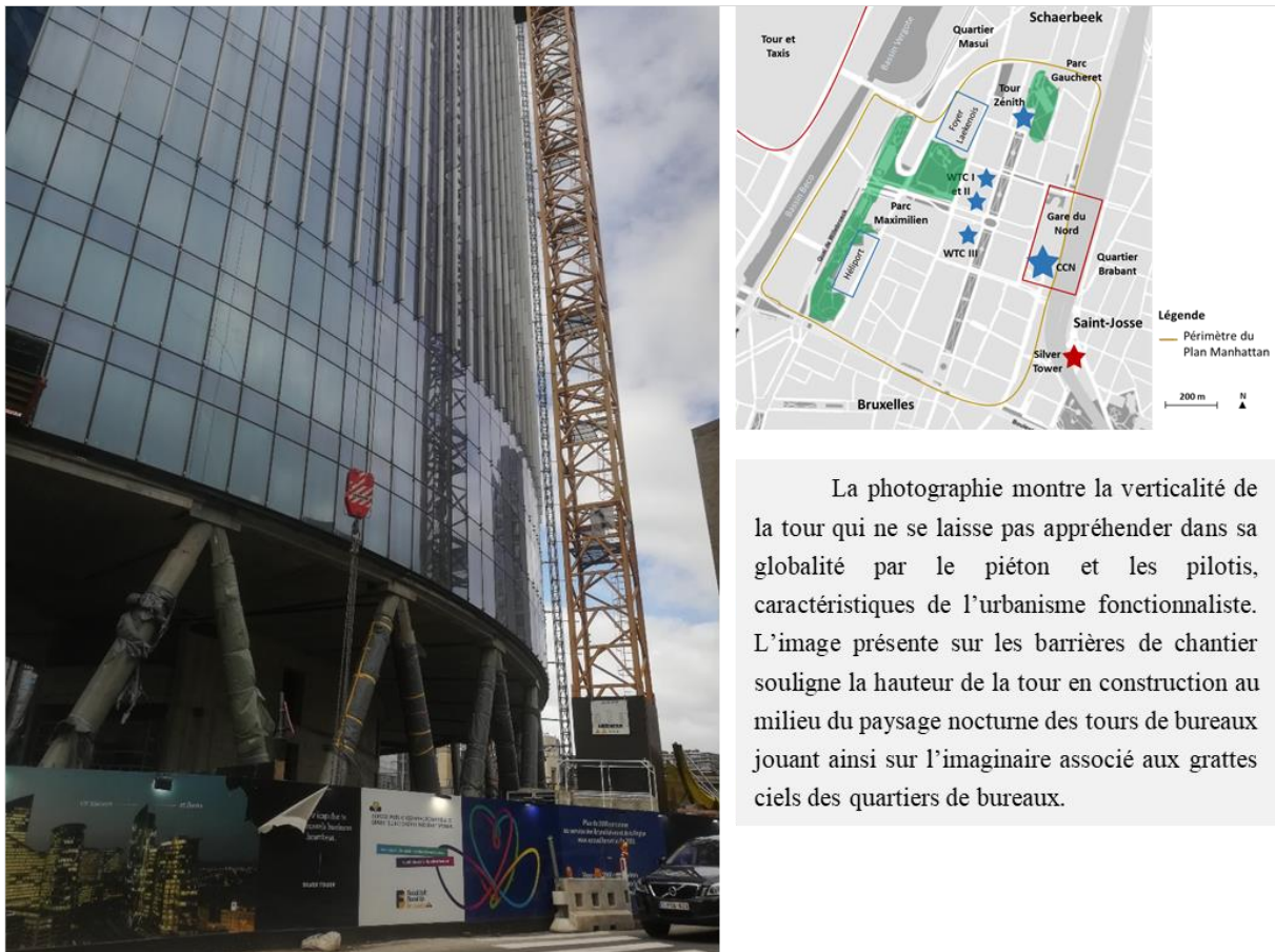
Photo 11. La Silver Tower en construction en 2020
